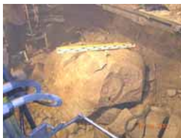
Валуны по трассе перегонного тоннеля
