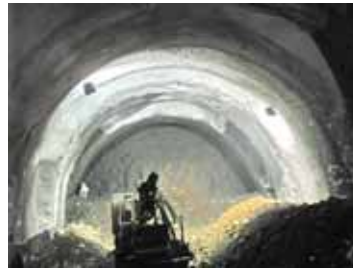
Устройство набрызг-бетонной крепи установкой Meuso Suprima
