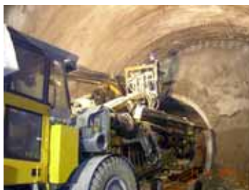
Устройство защитного экрана из труб буровой установкой Atlas Copco
