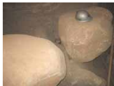
Валуны по трассе перегонного тоннеля
