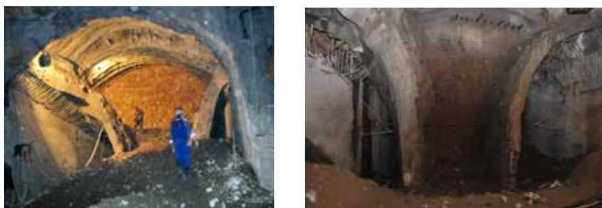
Средний тоннель станции колонного типа
