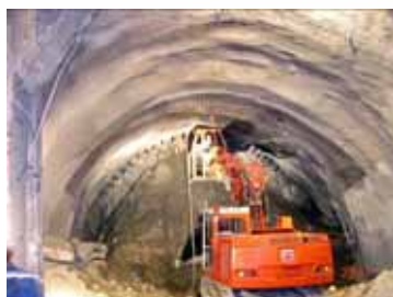
Разработка забоя тоннельным экскаватором Liebherr R-932
