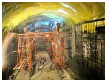
Монтаж арматуры постоянной обделки
