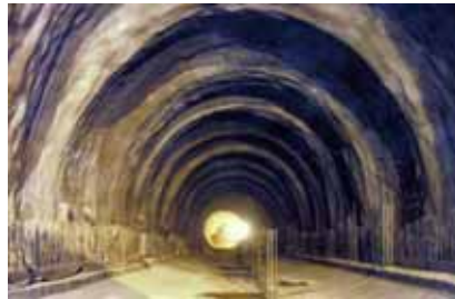
Временное крепление тоннеля при проходке методом НАТМ и железобетонный лоток обделки
