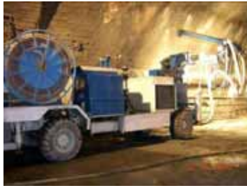
Устройство набрызг-бетонной крепи установкой Meuso Suprima
