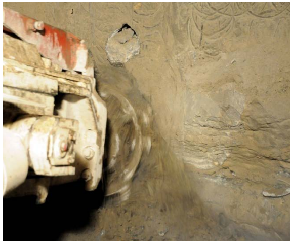
Рис. 7. Проходка штольни в закрепленном массиве.
