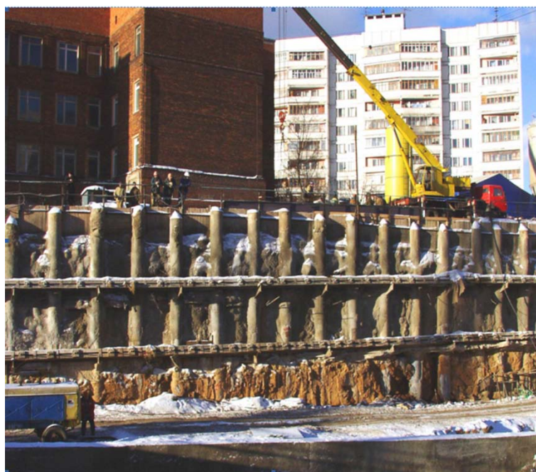
Рис.3. Пример использования комбинированной ограждающей конструкции (необводненные грунты).
